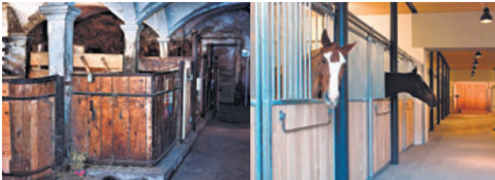
Von historisch-beengend zu modern-rationell: Vorher-/Nachher-Ansicht des bereits renovierten Südteils des Marstalls mit 16 Boxen (ohne direkten Auslauf). Der zweite noch auszubauende Stalltrakt wird 12 Boxen aufweisen. Die (wegen einer Grundwasserzone) asphaltierten Paddocks sind ebenfalls bereits zum Teil realisiert. Noch offen ist die Nutzung des denkmalpflegerisch wertvollsten, historischen Marstalltrakts.
