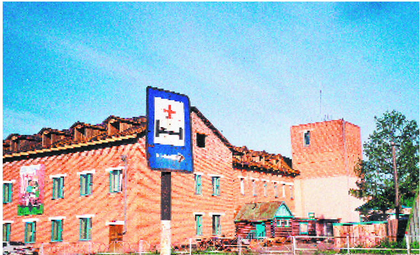
Ein Aimag-Spital in einer Provinz der Zentralmongolei
