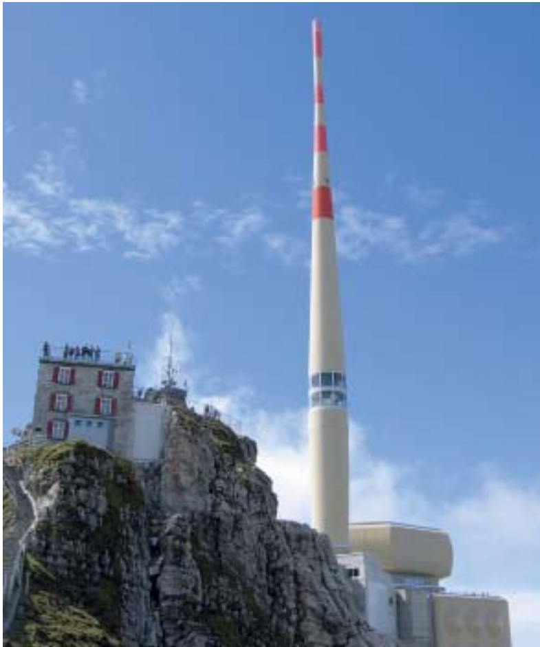
Angstbesetzt, bis jetzt aber freigesprochen: Mobilfunkantennen (wie hier auf dem Säntis)
